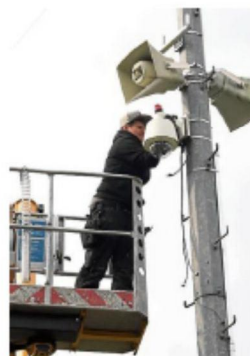
Lena Mazurier installiert die Kamera an einem Flutlichtmast.
